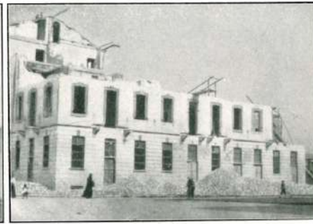
UN ANGOLO IN DEMOLIZIONE
