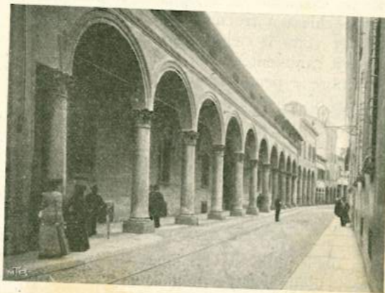
Palazzo Marsili. (Esempio di edifici senza facciata).
